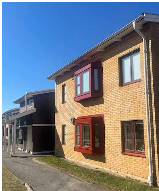
Stationsgatan efter renovering av fönster, fönsterdörrar och säkerhetsklassade ytterdörrar.
