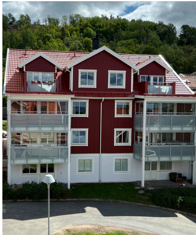
Kvarter Per 7 efter renovering.
