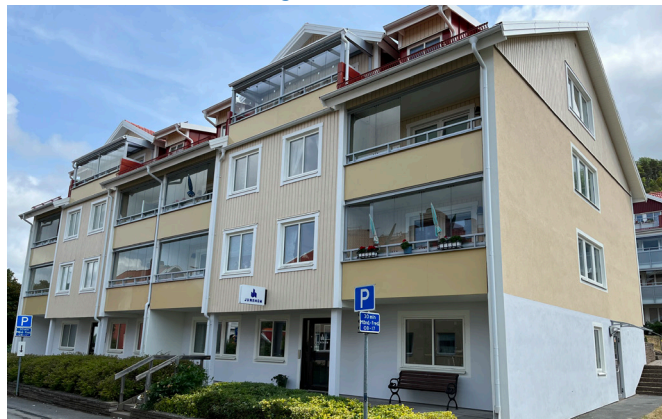
Kvarter Per 7 efter renovering.
